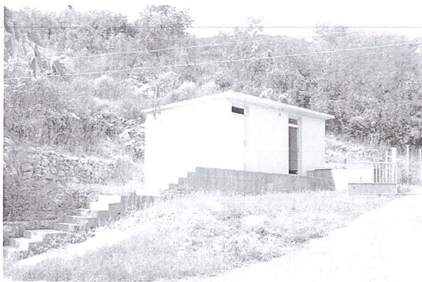
Pumpna stanica Oraška jama – novi pogon
